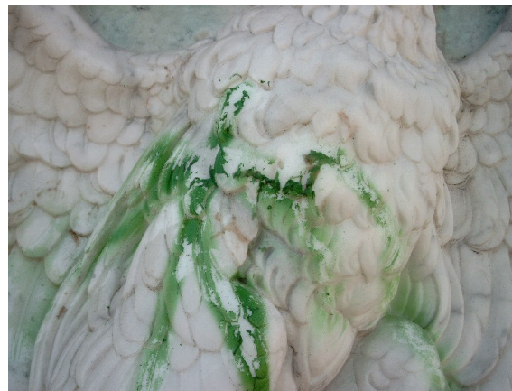
Aktivierung der Schutzschicht durch warmes Wasser: Die Farbschicht blättert, bzw. pellt sich rückstandslos von der Marmoroberfläche ab.
